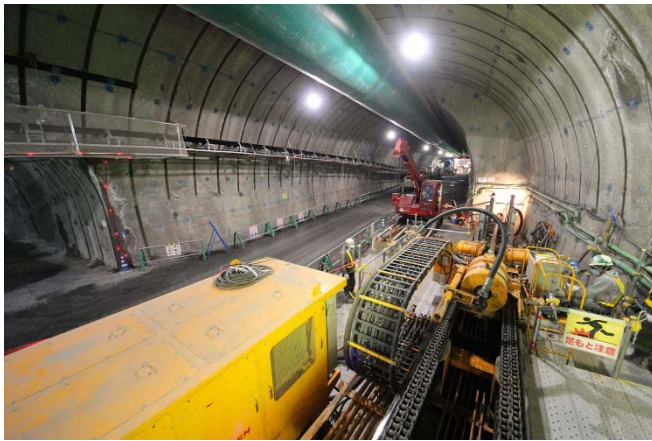
写真-1 非常駐車帯部における施工状況
