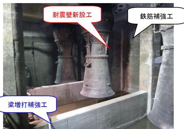
写真-10 ポンプ井施工完了状況
