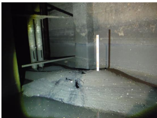
写真-4 ポンプ井浚渫前
