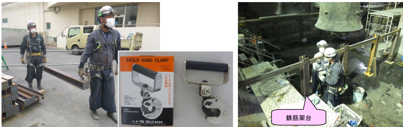
写真-8 鋼材運搬状況（左・中） 架台組立状況（右）
