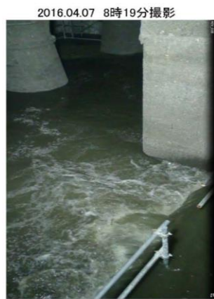
写真-2 ポンプ井雨水流入状況（前・後）
