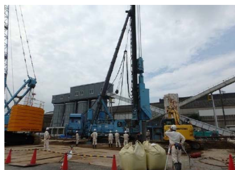
写真-3 埋込み杭工法オーガ掘削状況
