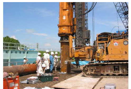
写真-6 杭衝撃載荷試験の現場実施
