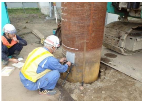
写真-1 打ち込み杭（鋼管杭）の打撃データ計測状況
