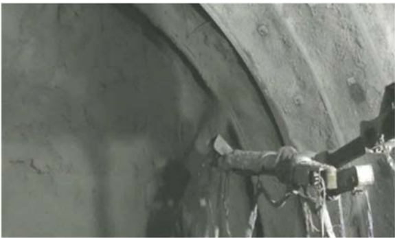
写真-2 吹付け作業状況
