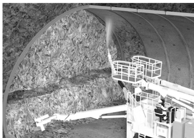
図-2 吹付けコンクリートの施工
