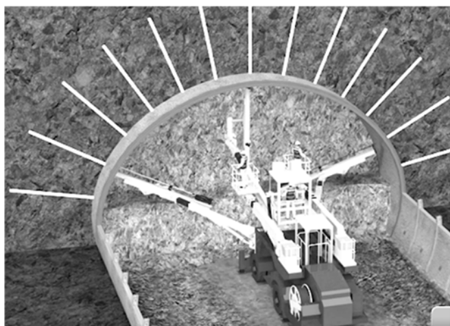
図-3 ロックボルト打設
