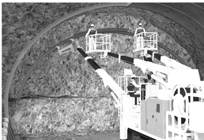
図-1 鋼製支保工建込み
