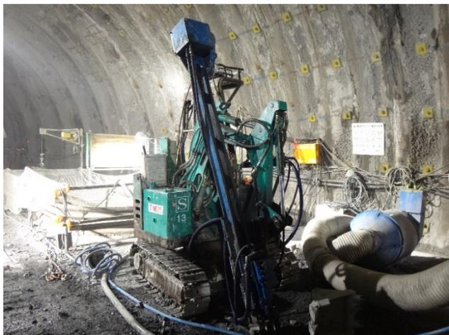
写真-1 小口径深礎掘削機
