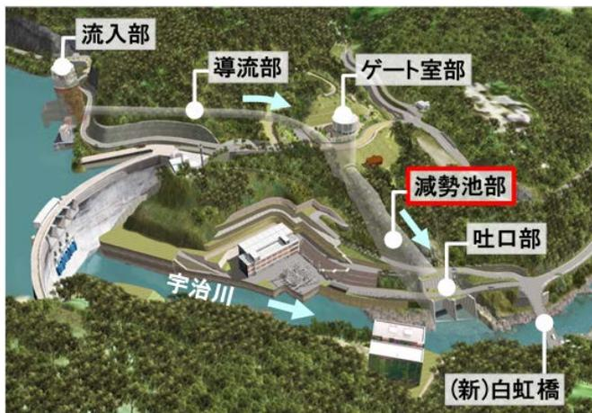
図-1 天ヶ瀬ダム再開発トンネル式放流設備配置図<sup>1)</sup>
