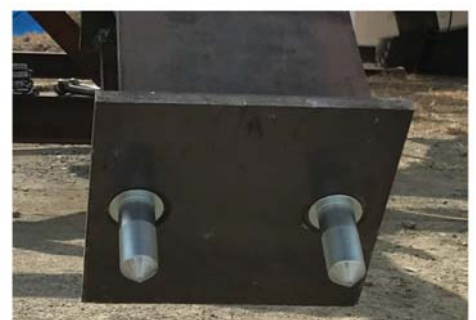
鋼製支保工継手
