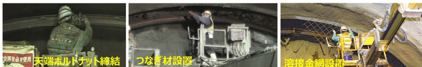
図-3 鋼製支保工天端部における作業状況
