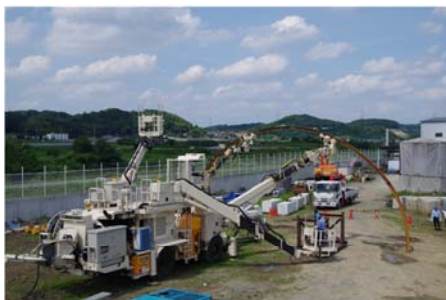
試験状況（後方より）
