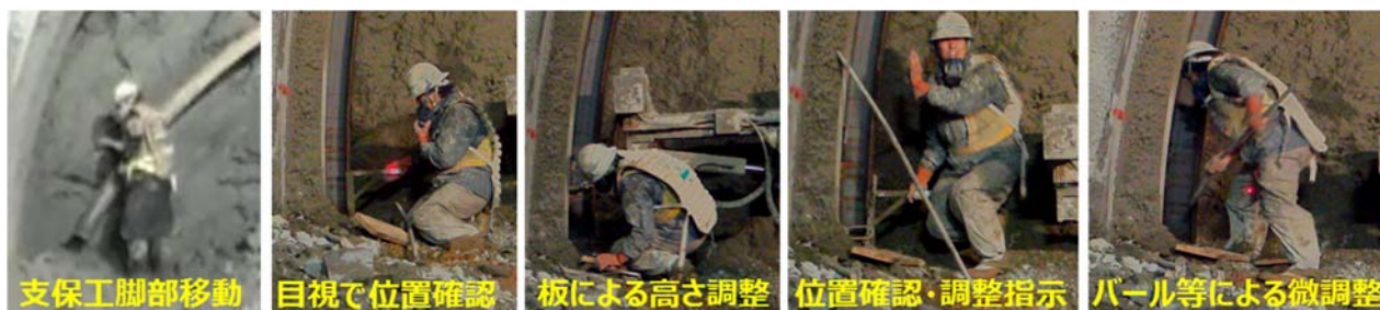
図-2 鋼製支保工脚部における作業状況
