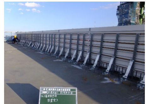
図-32 アルミ合金製埋設型枠
