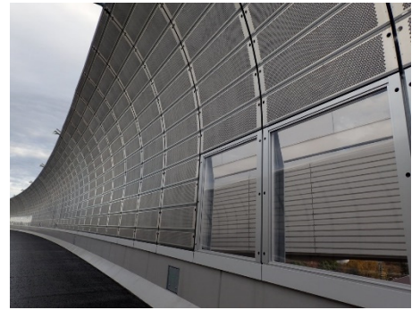
図-31 壁高欄・遮音壁全景
