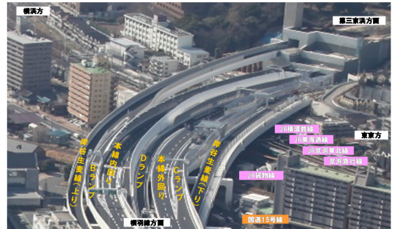
図-2 横浜北線鉄道交差部全景
