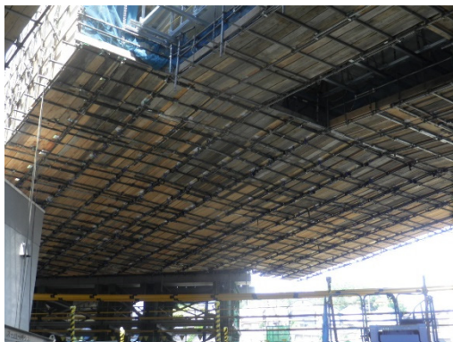
図-29 裏面吸音板吊り足場全景
