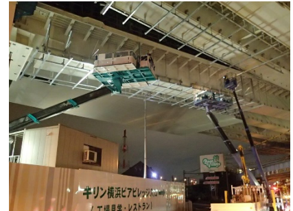
図-27 裏面吸音板（設置状況）
