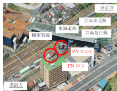
図-20 ケーソン施工箇所全景
