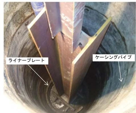
写真-2 覆工支持杭建込み状況
