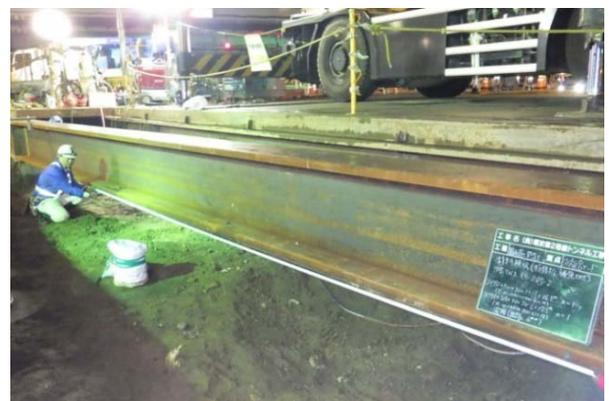
写真-1 長大スパン 覆工受桁架設状況
