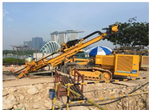
写真-2 削孔機
