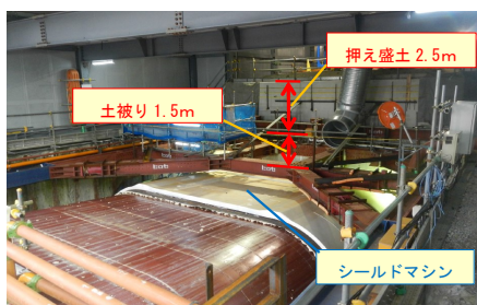
写真-2 シールド発進状況
