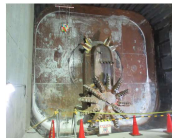
写真-5 シールド到達状況
