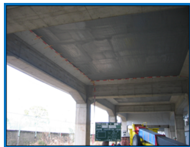
写真-12 高架橋の施工例
