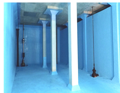
写真-11 上水用配水池の施工例
