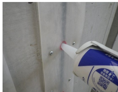
写真-2 シリコンゴム ( t=2\text{mm} ) と注入孔
