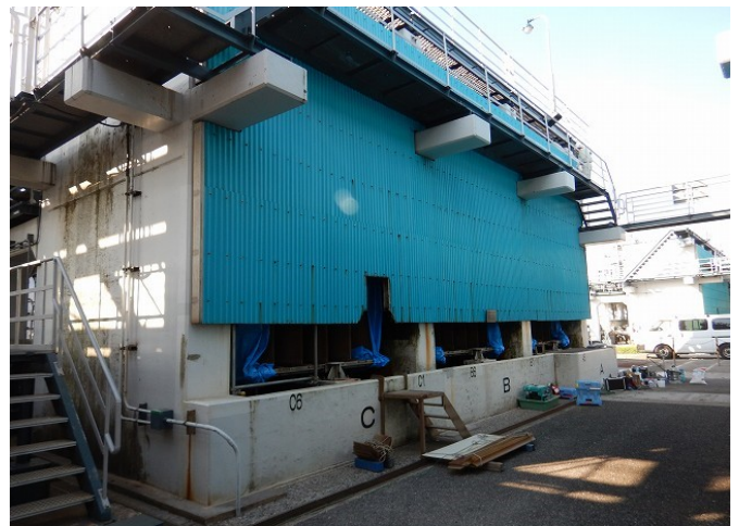
写真-2 B 基の外観
