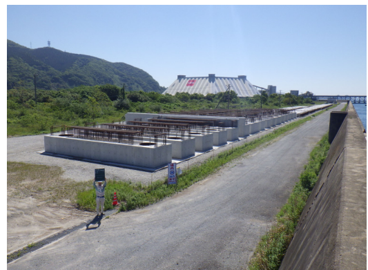
写真-4 プレキャスト部材全景
