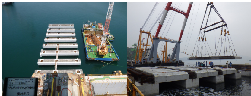
写真-5 プレキャスト部材の架設
