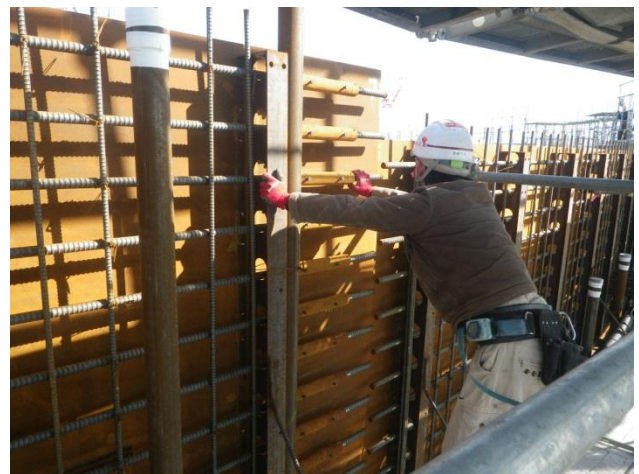
写真-9 コンポジット搭載状況-4
