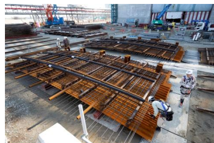
写真-5 コンポジット地組完成
