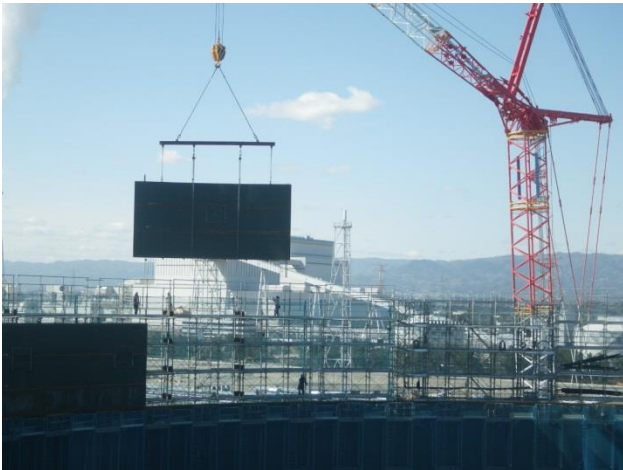
写真-6 コンポジット搭載状況-1
