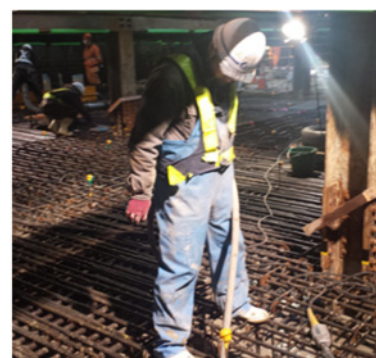
写真-3 ADS を使用した振動締固め状況
