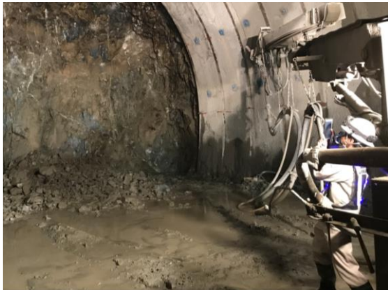
図-15 余掘り評価用の写真撮影風景
