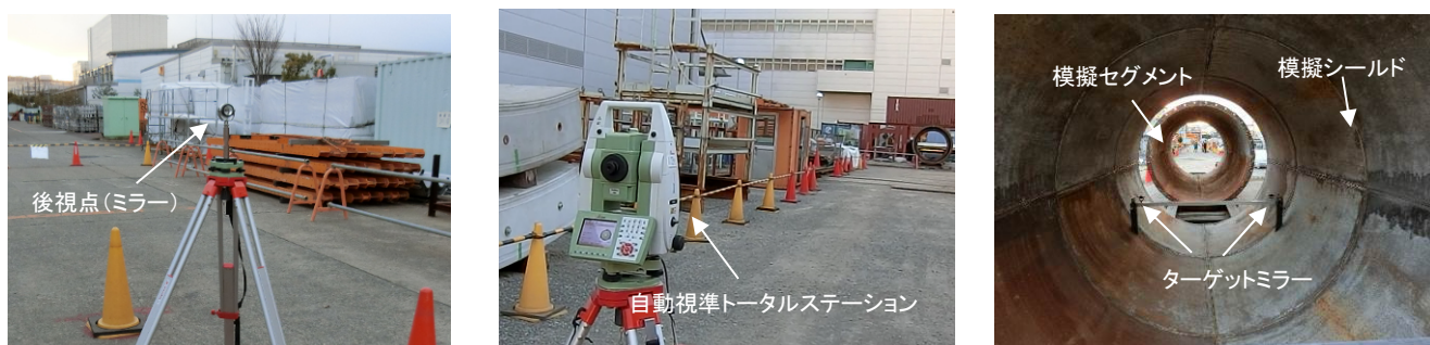
図 9 動作確認試験状況
