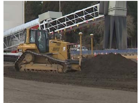
図-5 敷均しマシンガイダンスシステムとその実施状況
