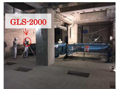
写真-2 計測状況。
