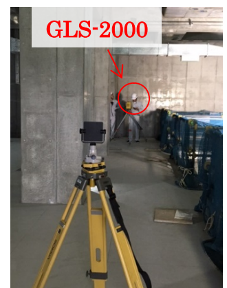
写真-3 計測状況
