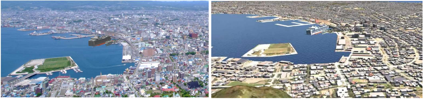
図 - 7 写真と CIM 画像の比較（左：写真に栈橋を合成，右：すべて CIM 画像）
