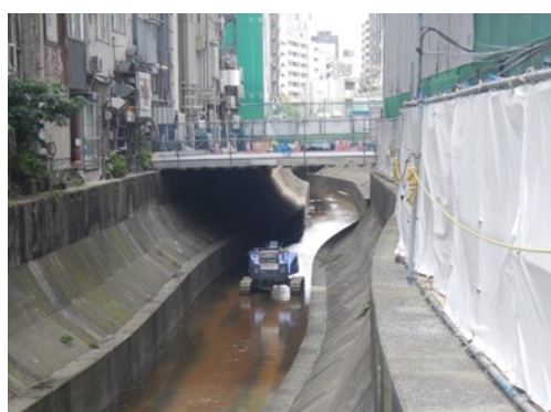
a 河川内での重機作業状況 (13:10)
