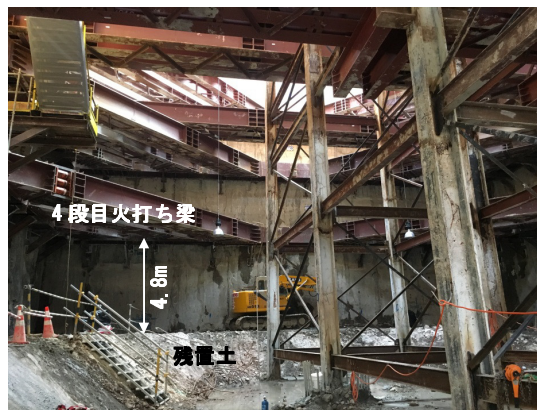
写真－4 施工状況（発進立坑内）
