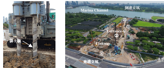
写真－１ 排土式工法 写真－２ 施工範囲空撮
