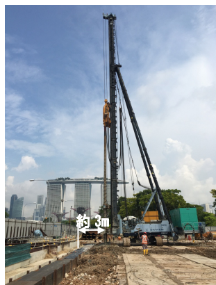
写真－3 施工状況（地上部）
