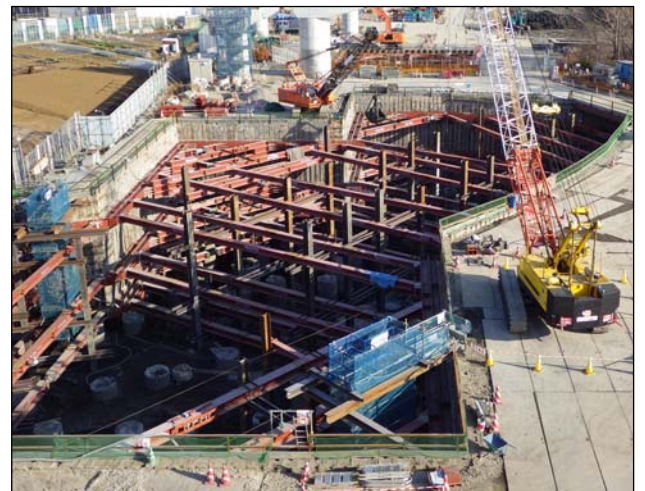
写真-1 ステップ4（最終掘削）施工
