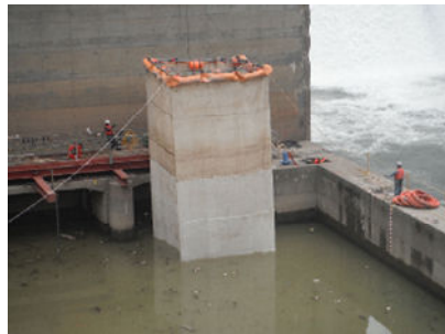
写真-5 汚濁防止膜設置状況
