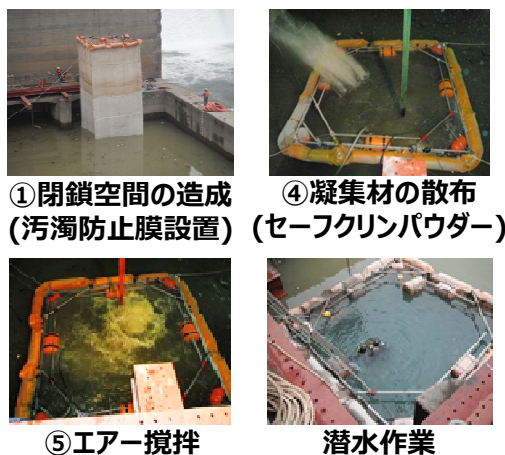
図-2 施工状況の写真
