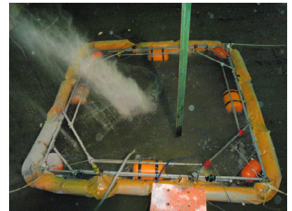
写真-6 凝集材散布状況
