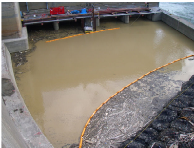
写真-4 施工前状況
