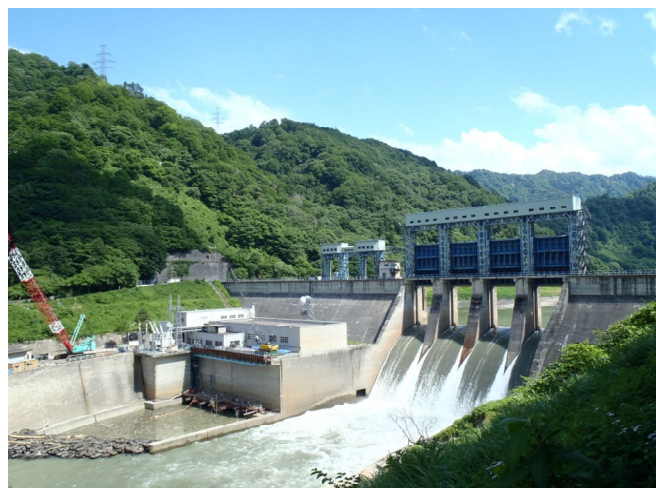
写真-3 現場全景写真
