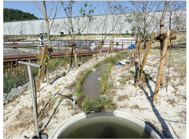
図-5 ビオトープせせらぎ部（竣工直後）
