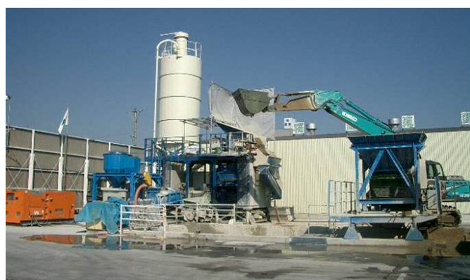
写真－2 不溶化処理の状況
