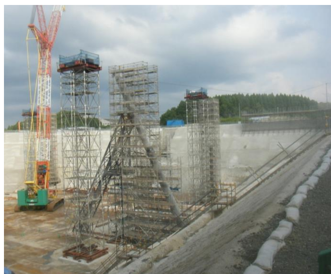
写真-2 中柱支保工
