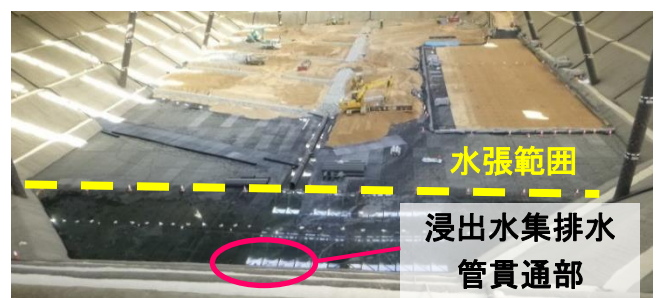
写真-9 水張試験状況
