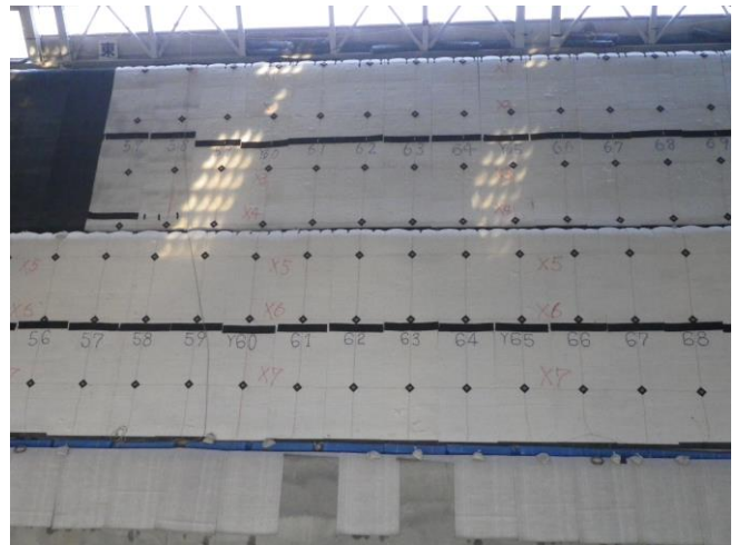
写真-8 法面部 測定電極配置状況
