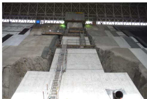
写真-5 斜樋形状集水ピット全景
