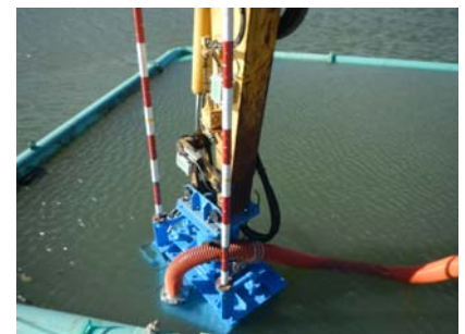
写真-2 浚渫装置の目印指標
