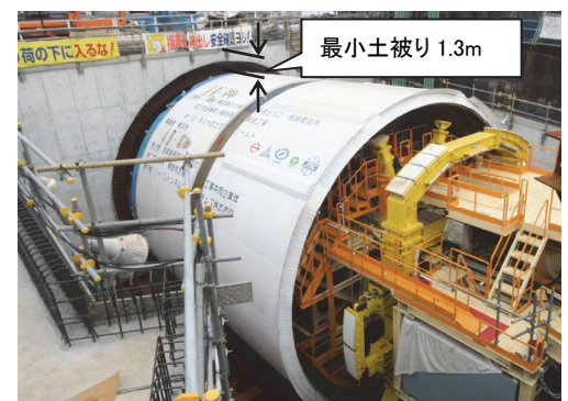
写真-1 シールド発進部状況
