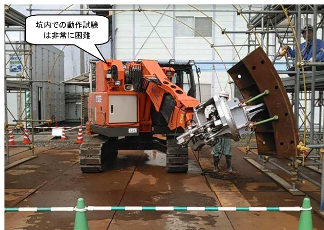
図-14 ハンドリング機の動作試験状況
