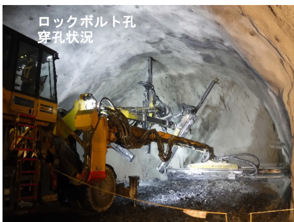
写真－2 フルオートジャンボによるロックボルト打設（マーキング不要）
