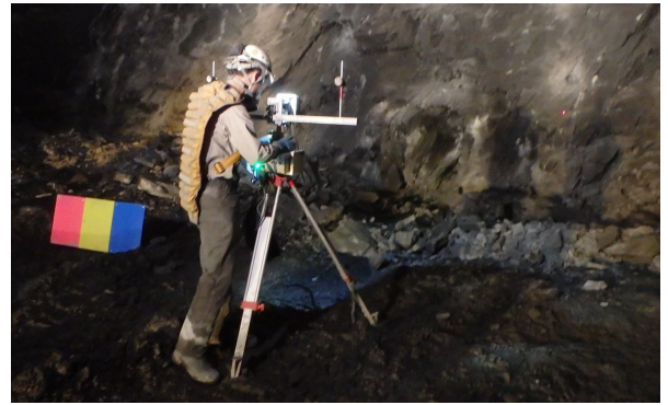
写真-3 掘削形状の測定
