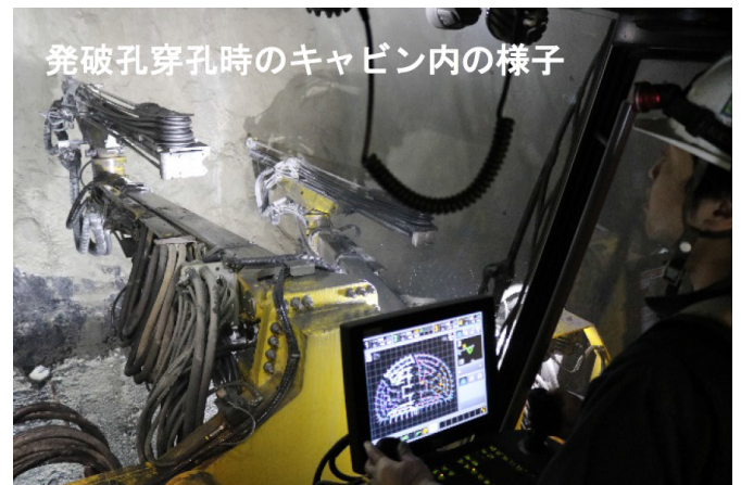
写真－1 4ブームフルオートジャンボ（専任オペレータによる自動穿孔）
