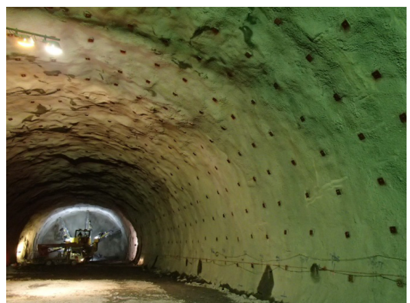
写真－2 フルオートジャンボによるロックボルト打設（マーキング不要）
