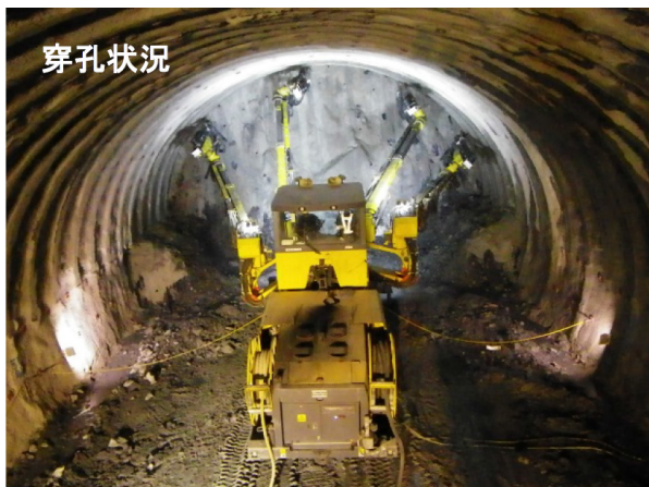
写真－1 4ブームフルオートジャンボ（専任オペレータによる自動穿孔）
