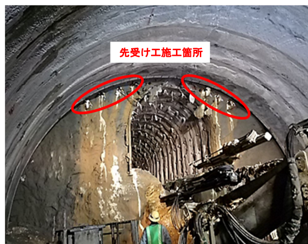
写真-3 本坑切り広げ時の先受け工施工状況
