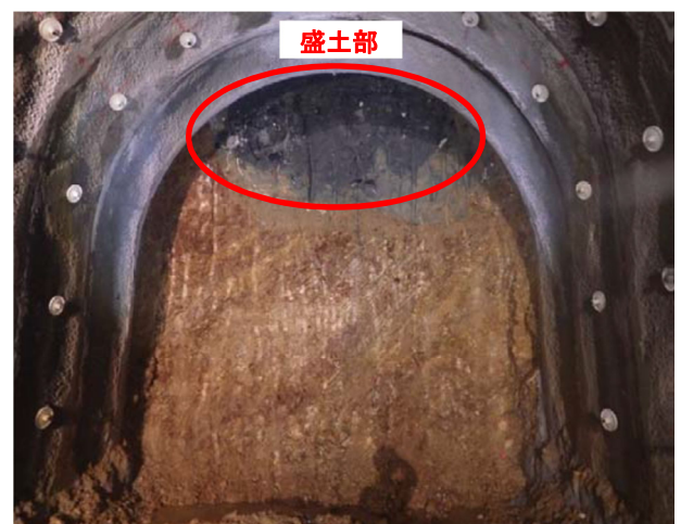
写真-1 先進導坑からの盛土部の露出
