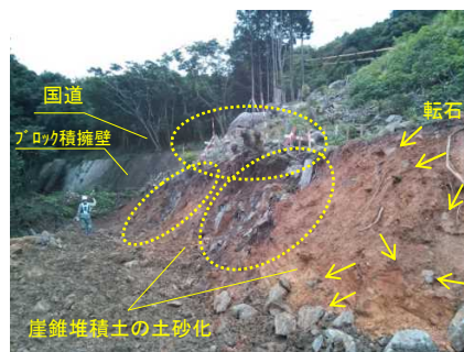
（上）伐採後掘削前、（下）抱き擁壁掘削前 写真－8 到達側坑口の転石の混入状況
