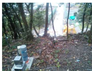
写真-6 層別沈下計の設置
