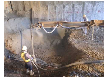
写真-5 早期閉合の施工状況
