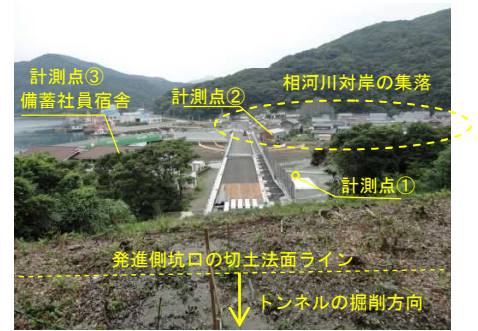
写真－13 発進側坑口の近接した集落
