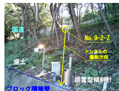
写真-11 ブロック積擁壁および 国道盛土の計測状況
