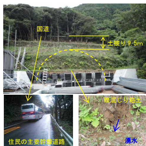
写真-4 発進側坑口の状況
