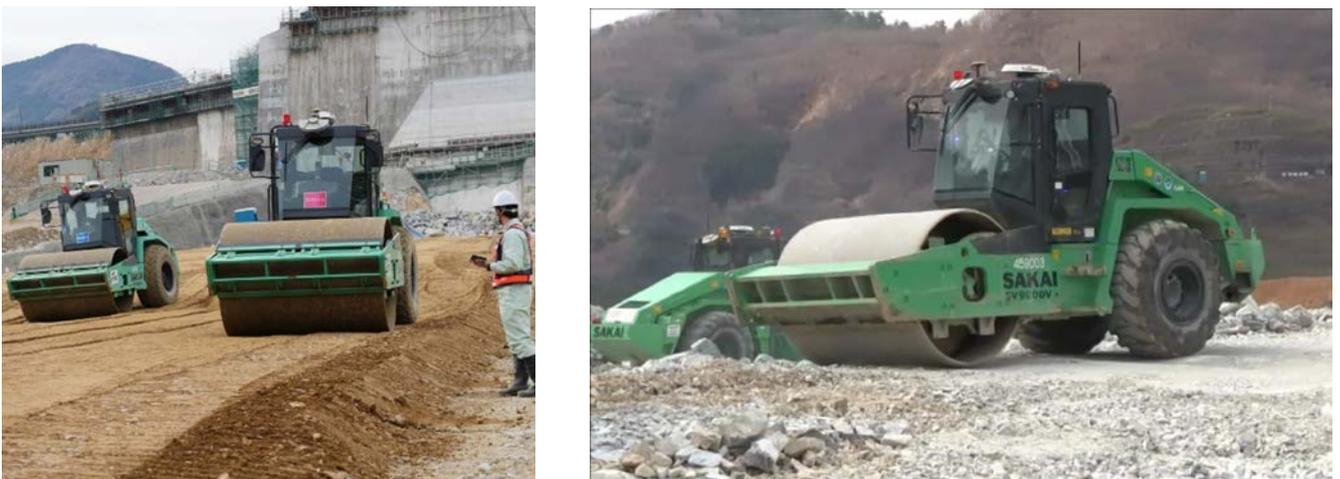
写真-2 ロックフィルダムでの振動ローラの運用状況
