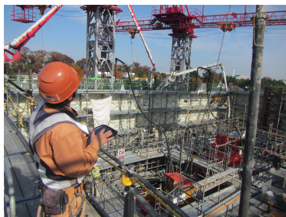
写真-3 コンクリート打込み状況 (タブレット操作状況)
