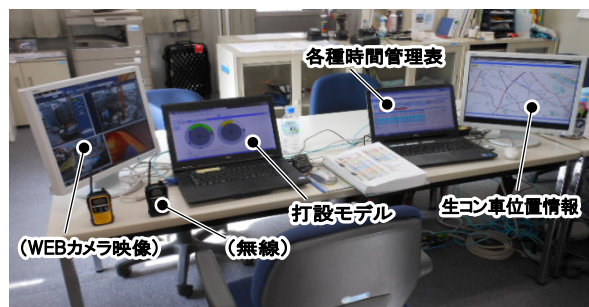
写真-2 コンクリート打込み管理室
