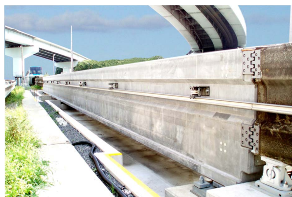
写真-2 UFC モノレール軌道桁（40m）
