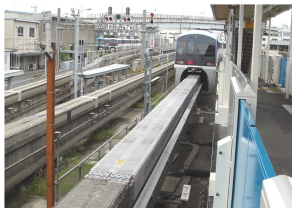
写真-3 供用中の UFC 軌道桁（20m）
