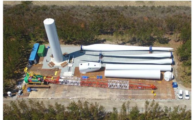
写真-3 風車部材仮置状況
