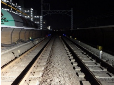
写真-8 軌道計測(全景)
