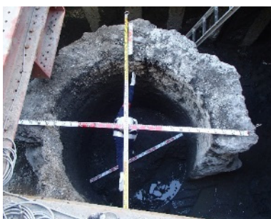
写真-2 場所打ち杭施工後に確認した地盤改良体 （掘り出す前は円環状に認められた）
