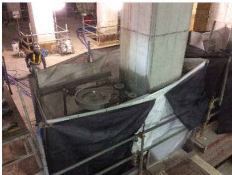
写真-5 ワイヤーソーによる既設柱切断
