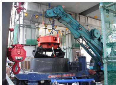
写真-1 低空頭機械による防護鋼管の施工
