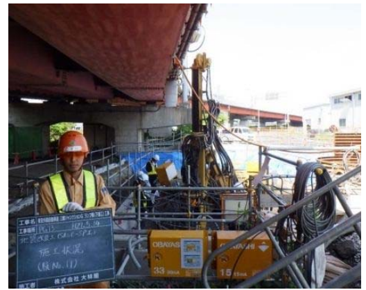
写真-1 SAVE-SP工 施工状況
