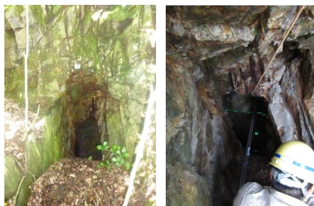
写真-4 現地空洞と計測状況
