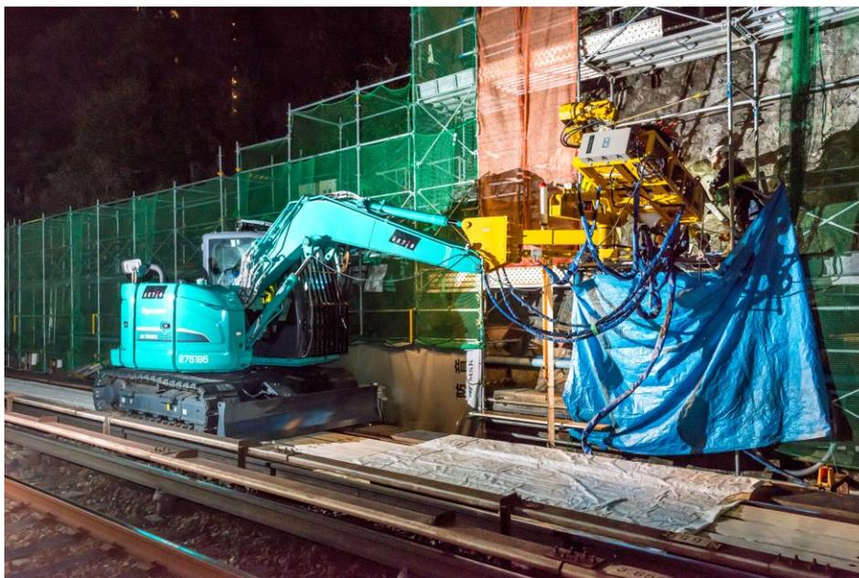
写真-3 地山補強材設置のための削孔状況(夜間作業)
