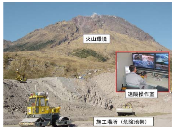
写真-1 無人化施工状況
