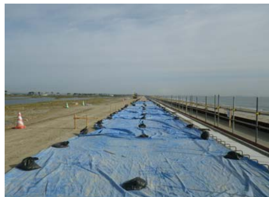
写真-4 CSG 養生状況
