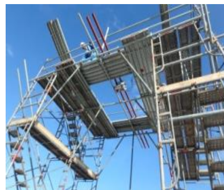
写真-5 測定状況
