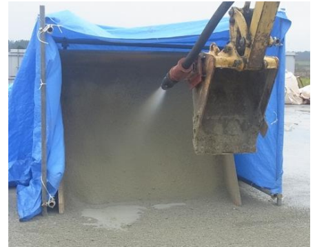
写真-3 吹付け状況
