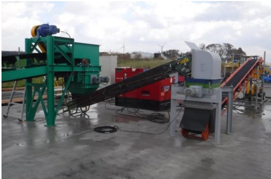
写真-1 吹付けシステム
