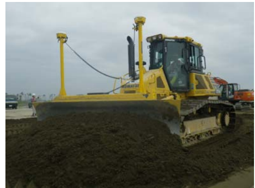
写真-2 21t 級湿地式ブルドーザ
