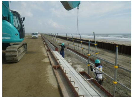
写真-5 鋼製型枠のスライド作業状況
