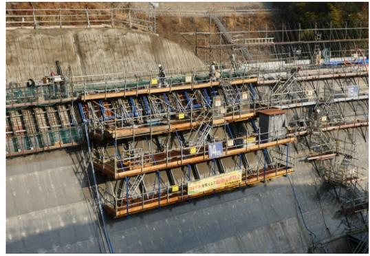
写真-2 自動スライド枠設置状況
