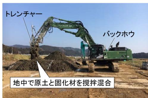
写真-1 中層混合処理工法の施工状況
