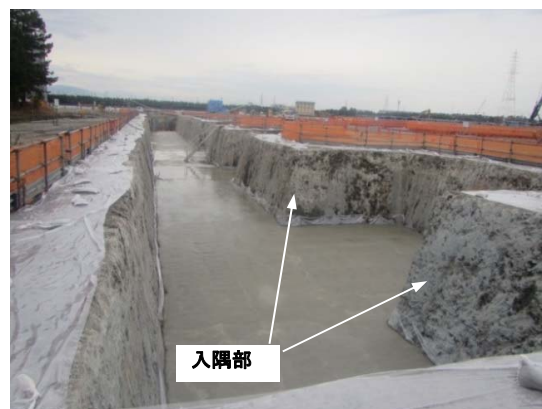
写真-3 掘削・均しコンクリート打設完了状況 (現場打ちカルバート区間)
