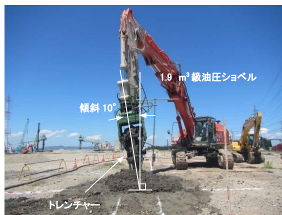
写真-1 土留め壁造成状況
