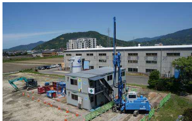
写真-1 試験施工状況
