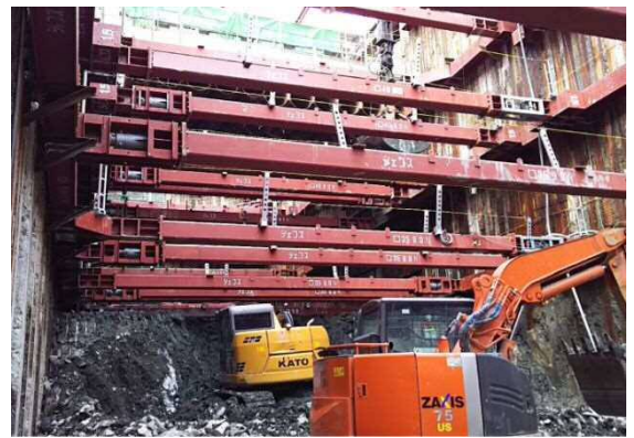
図-8 Eco ラム工法（中間杭省略）による掘削状況
