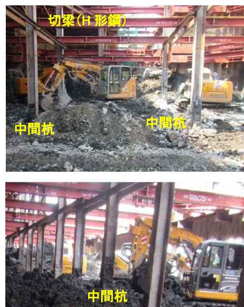
図-5 従来工法による掘削状況
