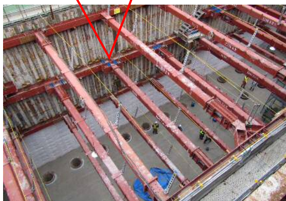
図-12 土留め支保工架設完了状況 (Eco ラム工法、トンボ火打ち)
