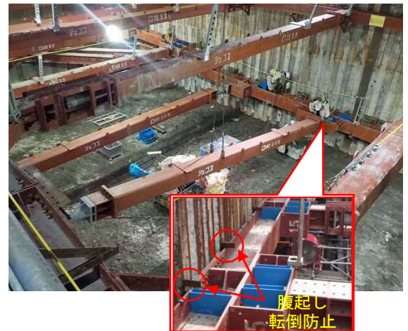
図-9 Eco ラムの架設状況
