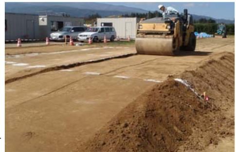
図-4 試験盛土の転圧状況
