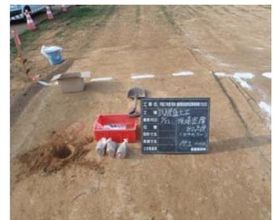
図-12 コアカッターによる試料採取
